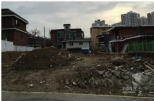
▲ 경기 의왕시 내손동 건축협정제도 시행지구58호동 668-1 등 총 4필지에 기존건물 철거 현장 모습.
